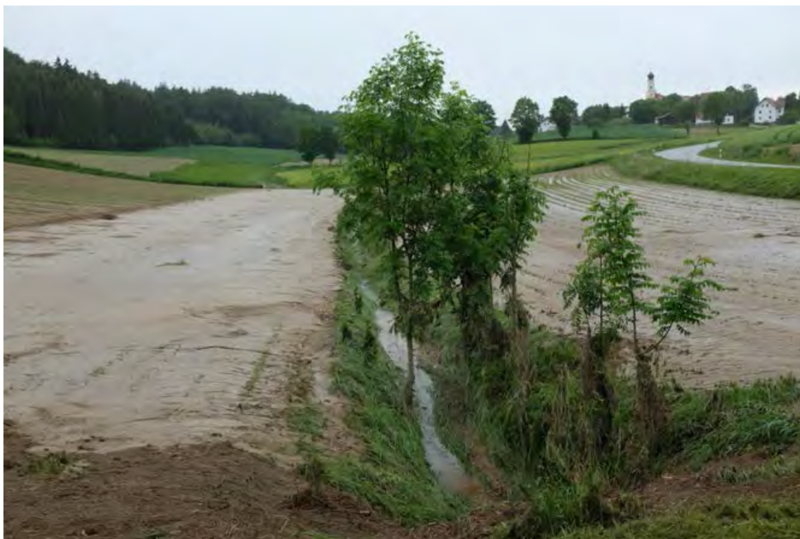
Abb. 100: Situation nach Ausuferung des Baches wegen verstopfem Durchlass (unten im Bild), Fließrichtung nach unten, Einzugsgebiet Kleine Laber. Beispiel für (ungeplanten) Wasserrückhalt
