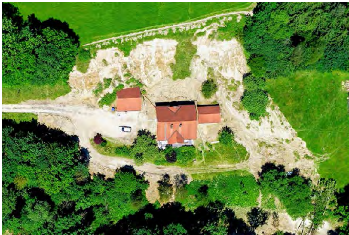
Abb. 56: Hangrutsch oberhalb Simbach, Luftbildaufnahme am 07.06.2016, W. Bauer, Agroluftbild Obertraubling
