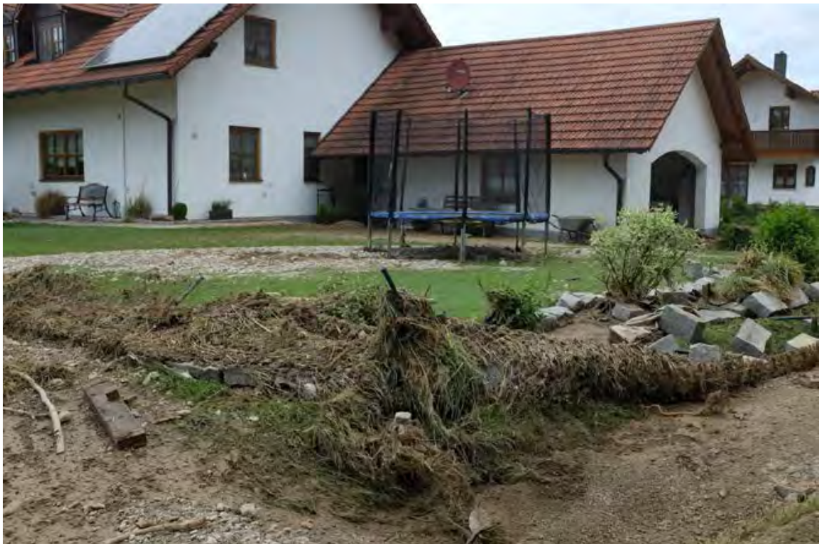
Abb. 74: Nach der Überflutung im Ortsbereich von Wolfsbach, Foto 31.05.2016
