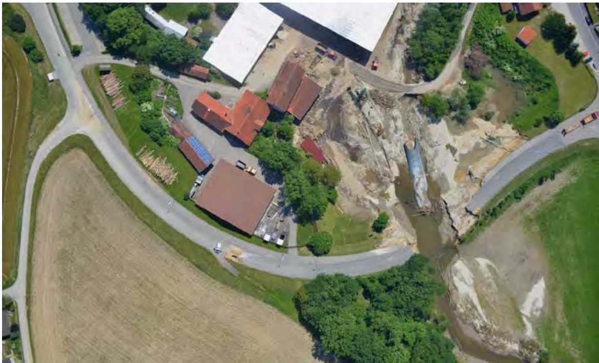
Abb. 65: Zerstörte Straße zum Schulzentrum Simbach, oberhalb des Sägewerks, Fließrichtung nach oben. Luftbildaufnahme am 07.06.2016, W. Bauer, Agroluftbild Obertraubling
