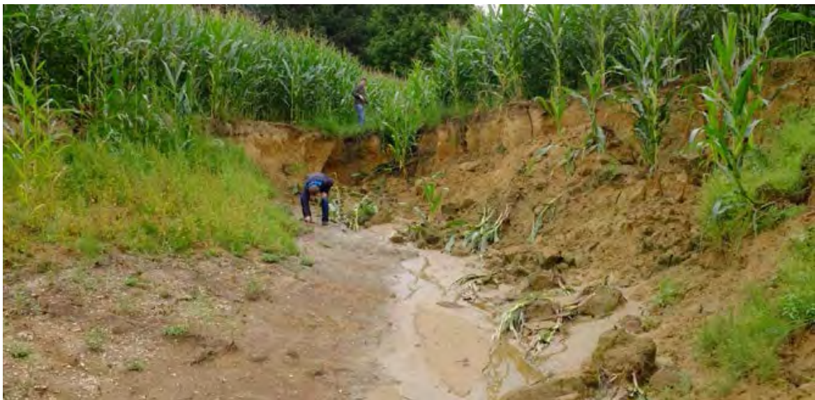
Abb. 46: Blick von „unten“ in die Auskolkung (Foto 10.08.2016). Seit dem Ereignis am 1.6. ist weiteres Bodenmaterial in den Kessel eingebrochen.
